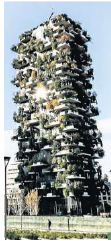
Das Original: der Bosco Verticale in Mailand.
