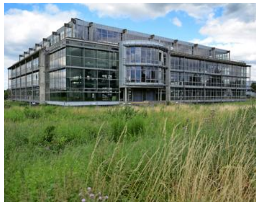
Das Gebäude aus Glas, Stahl und Beton auf der Göttinger Siekhöhe wurde in den 90er-Jahren gebaut, ist im Rohbau stecken geblieben und steht seitdem leer. Christina Hinzmann/GT
